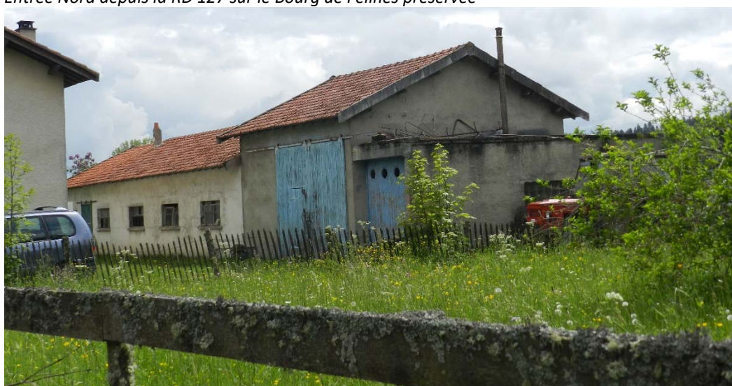
Annexe agricole, ancienne porcherie qui sera démolie
