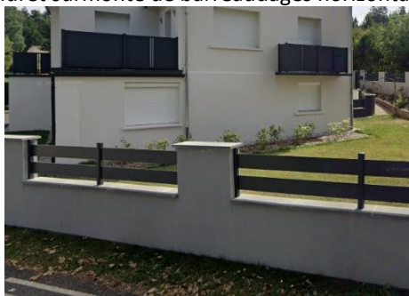
Muret surmonté de barreaudages horizontaux
