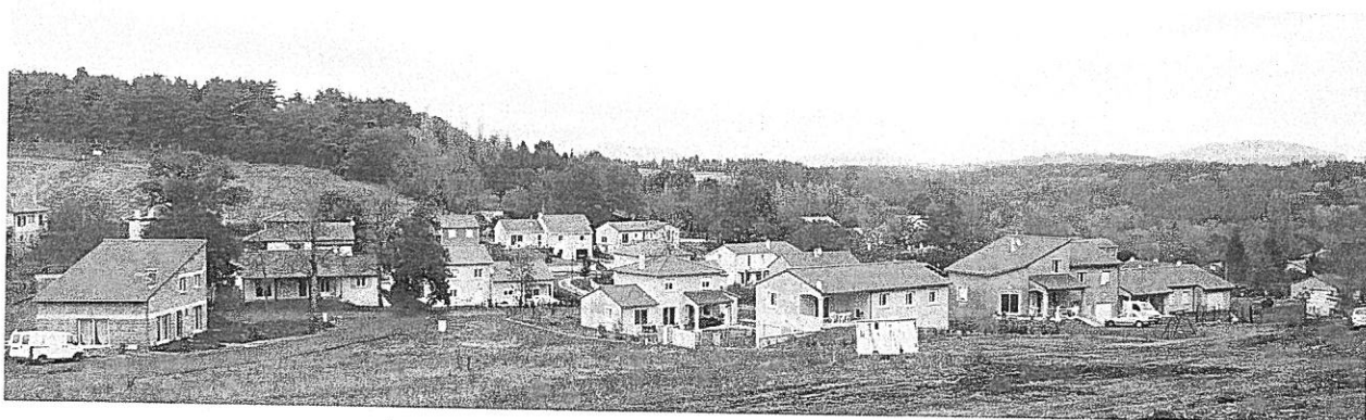
Un nouveau quartier pavillonnaire a été crée au Nord-Ouest du Bourg vers La Chazotte
