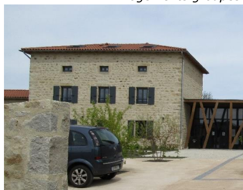
Logements collectifs en réhabilitation
