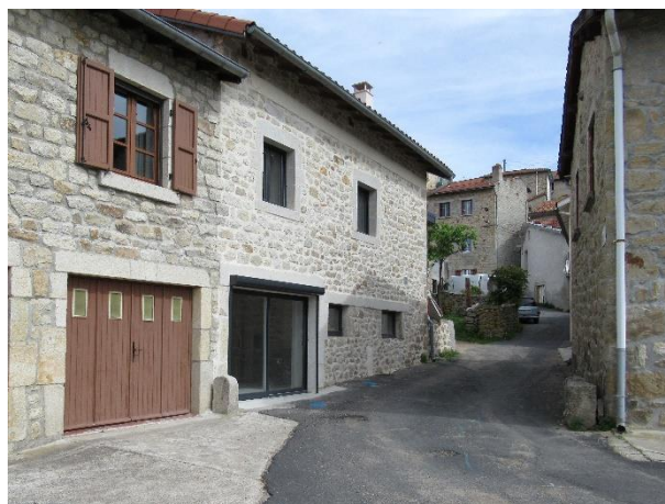
Réhabilitation dans le centre ancien
