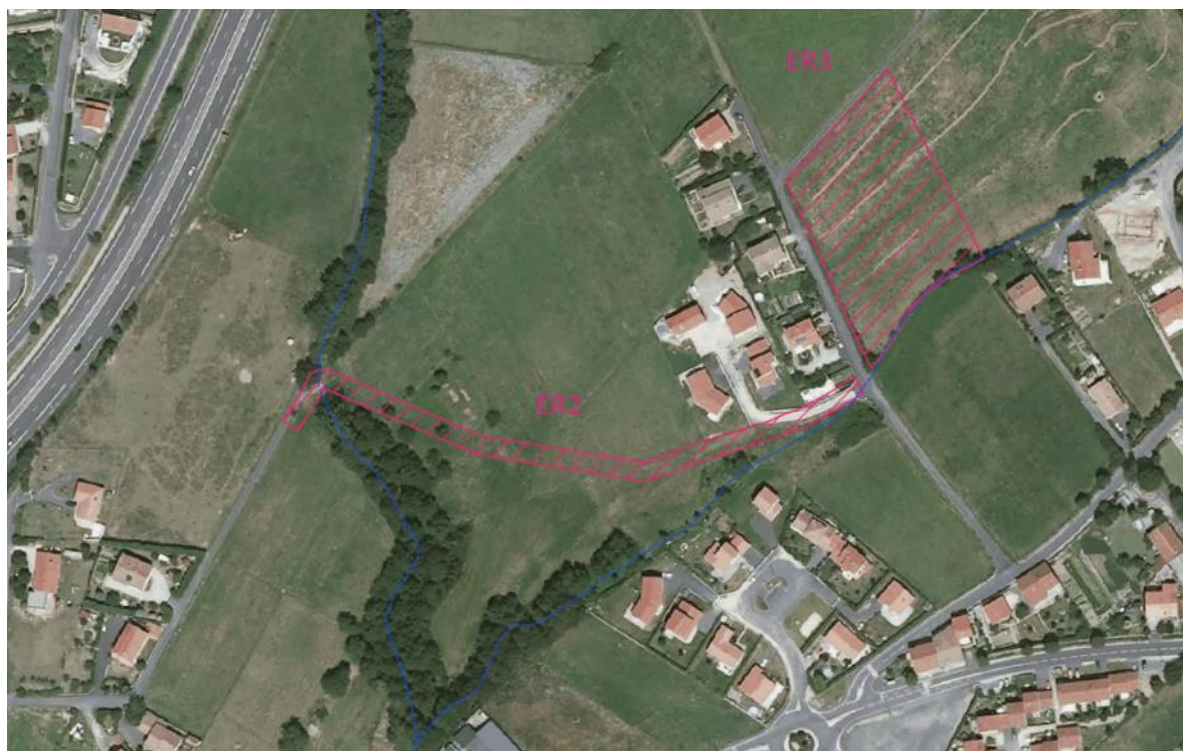
Figure 84 – Vue de l'emprise de l'ER2 et ER3
