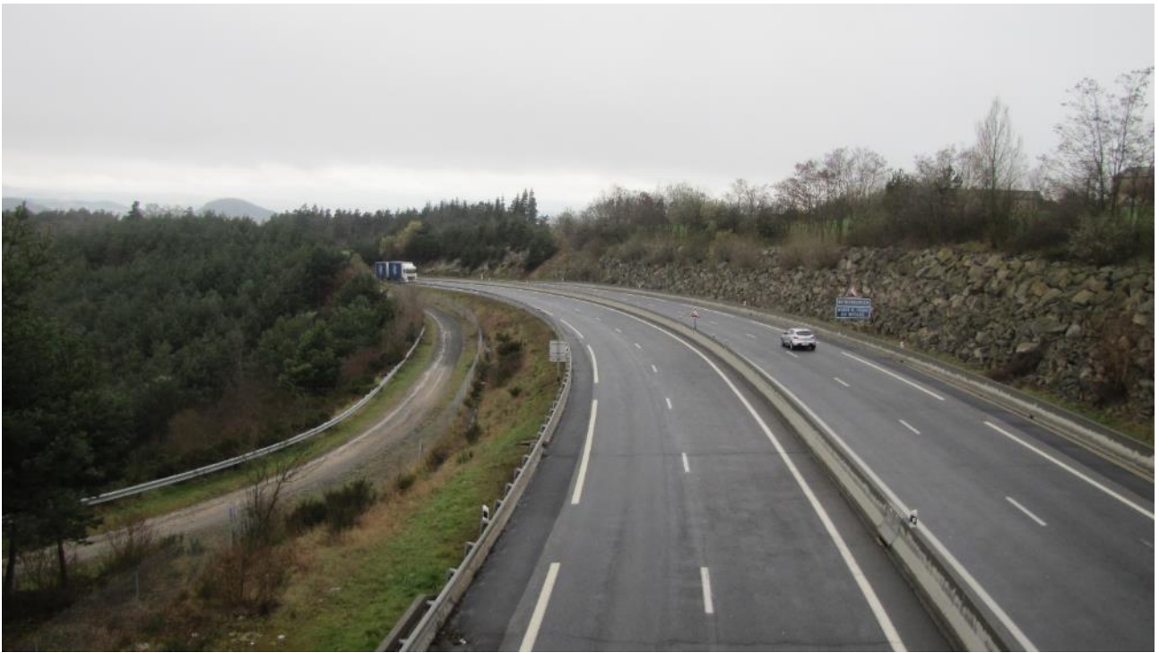
Photographie 59 – Vue sur la RN 88 (02/04/2016)
