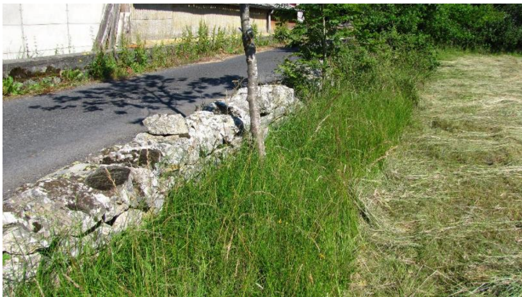
Figure 77 - Localisation et vue du secteur sud-ouest de l'OAP 4
