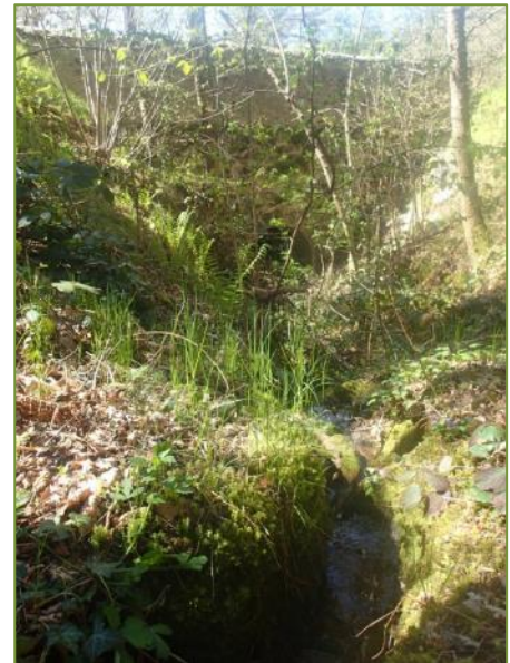
Photographie 46 – Ruisseau temporaire descendant le talweg et traversant la RD9887 – Lieu-dit « Les Roches de Malpas » (04/05/2016)
