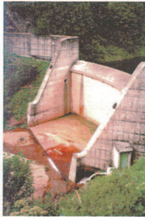
Barrage EDF de la Veyradeyre - Complexe de Montpezat Source FDAAPPMA 43
