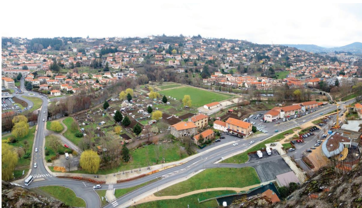
Vue depuis le rocher d'Aiguilhe vers le coteau de Chosson
