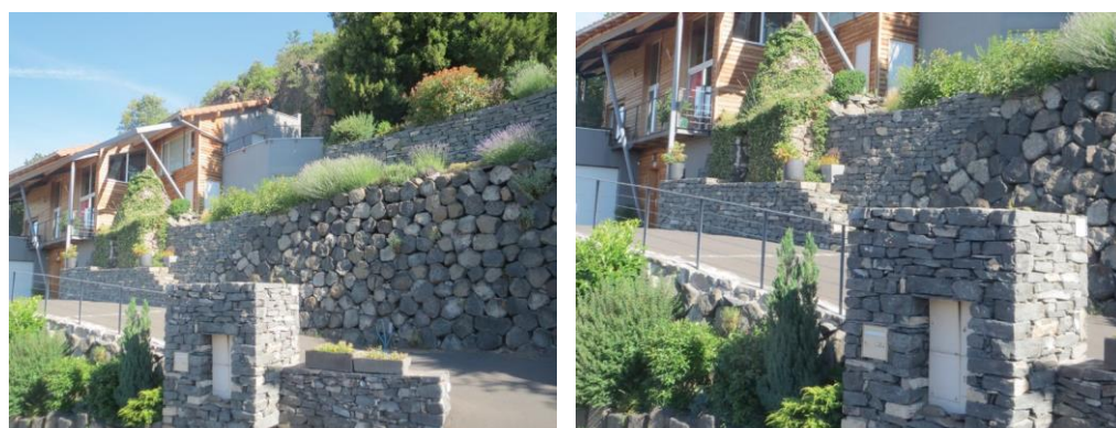
Coffrets et boîte aux lettres encastrés dans un élément architectural (Aiguilhe)
