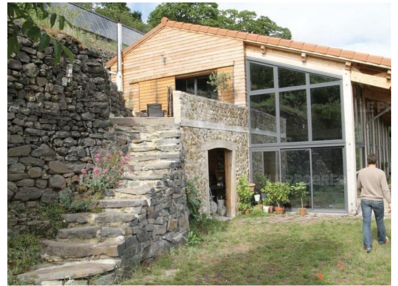
Exemplarité d'une maison à cheval sur une chambée (Aiguilhe)
