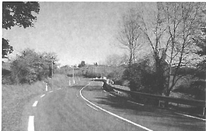
Sud-ouest : vue depuis la RN 89
