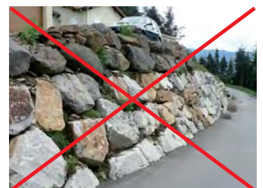
Exemple d'enrochements de type cyclopéen
