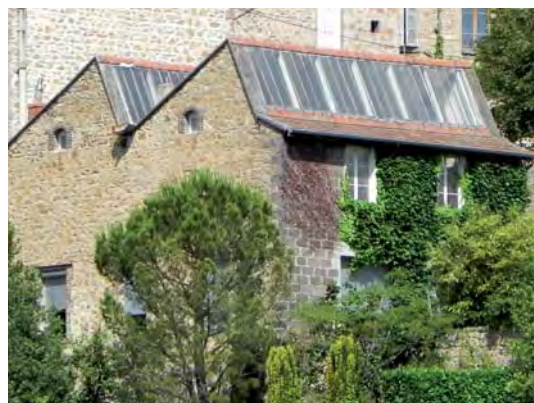
Exemple de toiture en Shed
