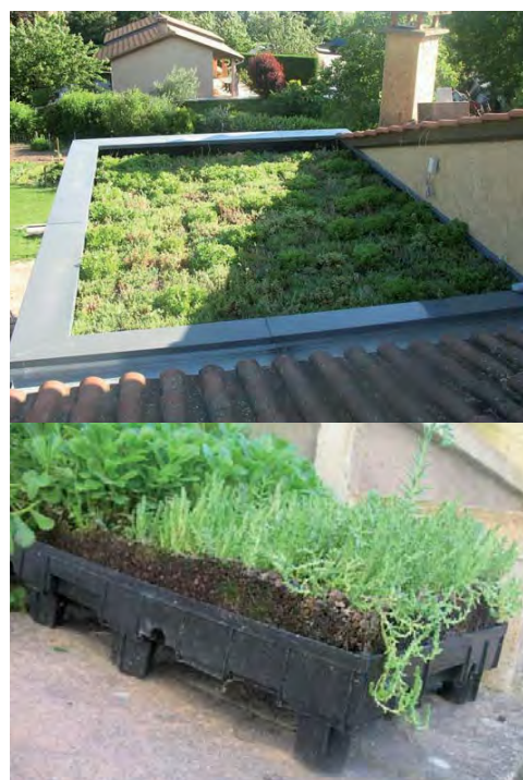
Exemple de toiture-terrasse végétalisée et bacs pré-cultivés
