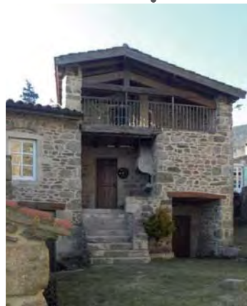
Exemple de débord de toiture
