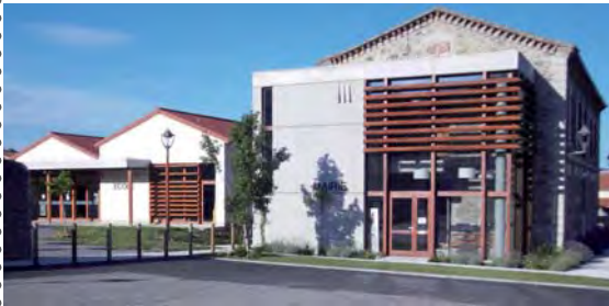
Exemple de lames orientées fixes
