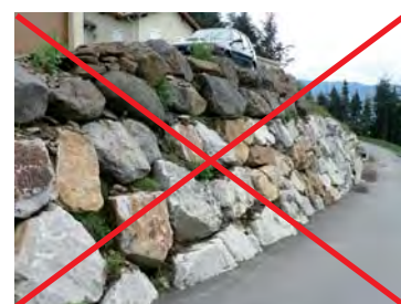
Exemple d'enrochements de type cyclopéen
