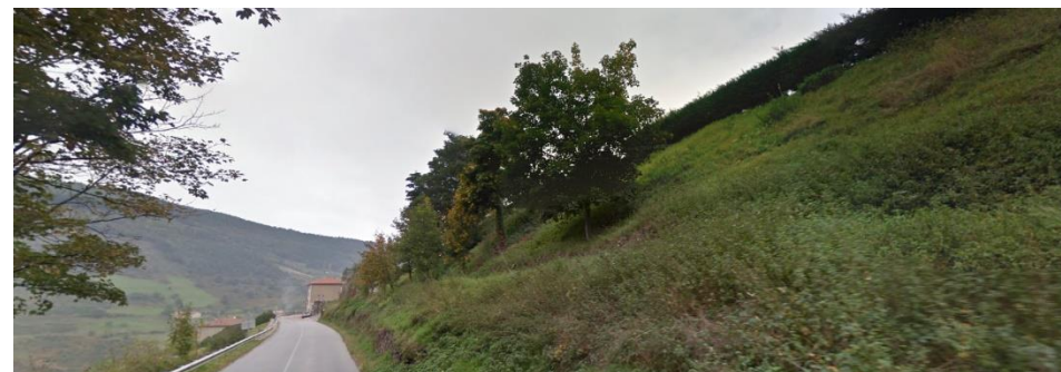
Vue sur le site de projet depuis la RD2
