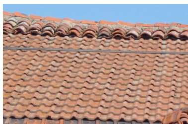
Tuile Romane à emboîtement. Inspirée de la tuile creuse traditionnelle, elle a été fabriquée de façon industrielle dès les années 50
