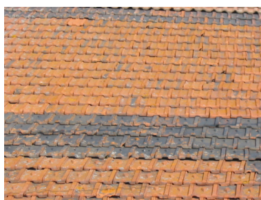
Tuile traditionnelle dite canal tuile demi cylindrique
