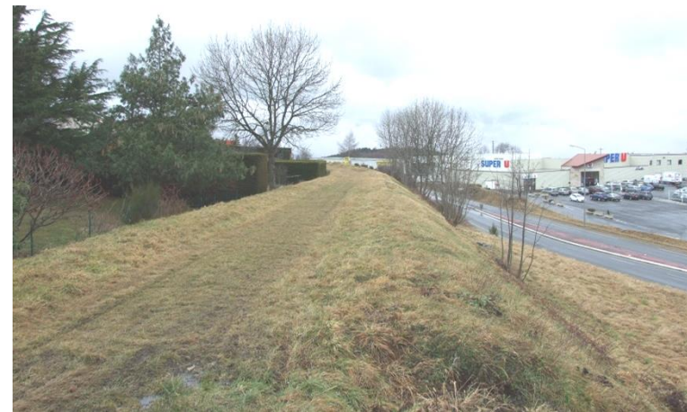
Le tracé de l'ancienne voie ferrée débouche en face du supermarché. C'est ici que va se prolonger le tronçon du contournement de Saint Bonnet
