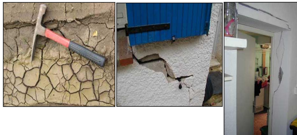
Illustrations du phénomène de retrait gonflement des argiles (source http://www.argiles.fr/ )
