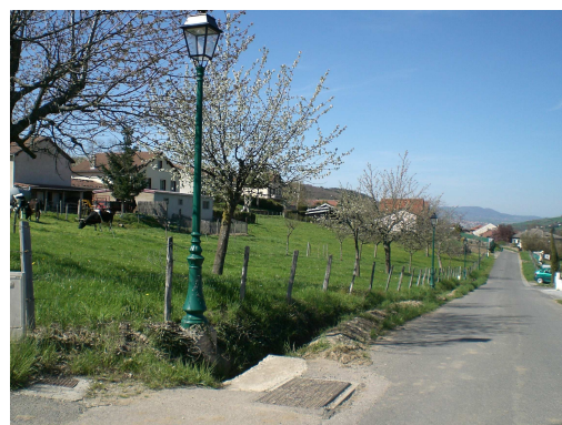
La rue du Petit Bois avant travaux
