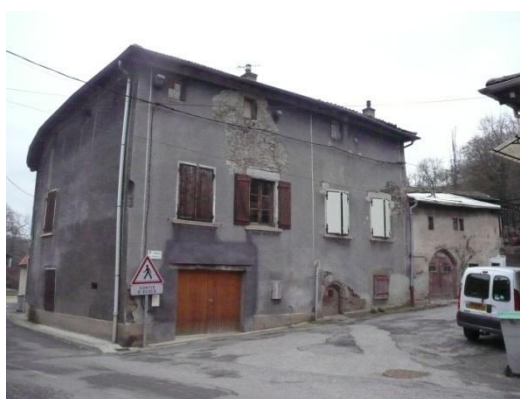
19/ Ancien hôpital : rue du Lozange – Parcelle A 641
