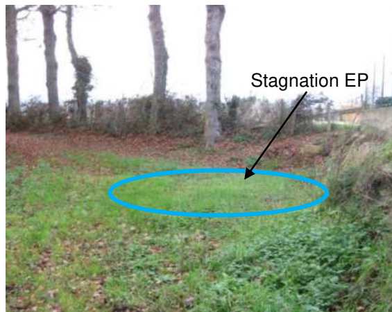
Fig. 26. Stagnation des eaux pluviales – Chemin Malefosse
