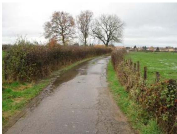
Fig. 38. Inondation – chemin de Plaines
