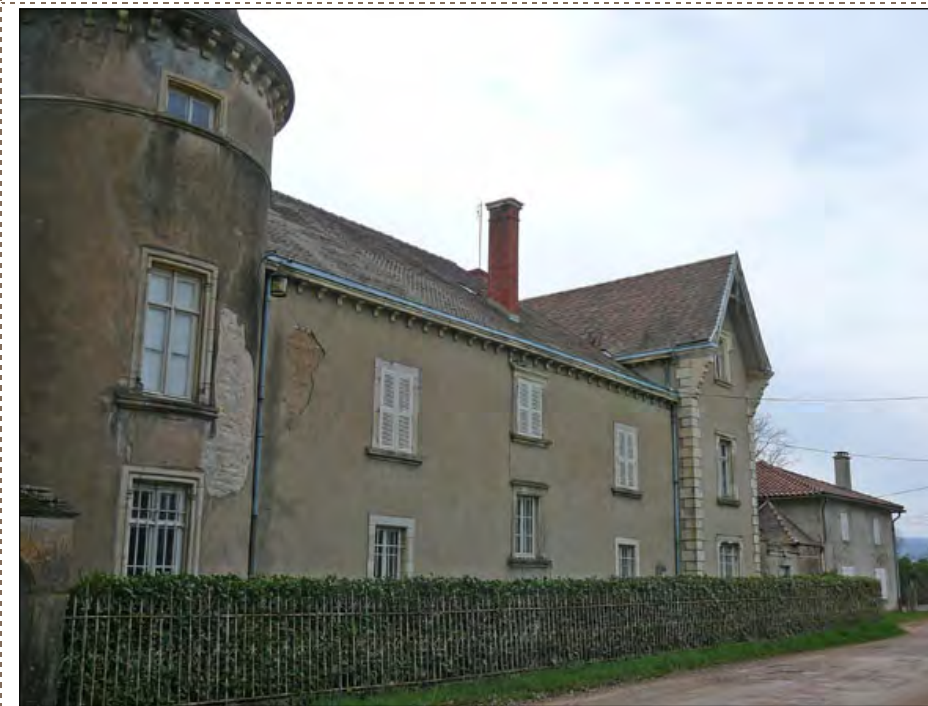
La Chapelle et la bâtisse associée « Haute Maison
