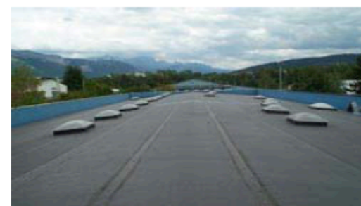
Toiture en membrane PVC
