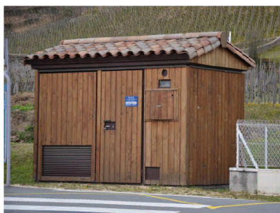
Exemple de local pour transformateur électrique
