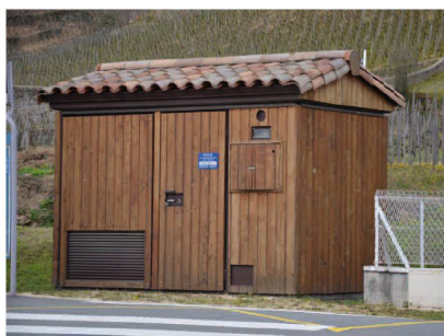
Exemple de local pour transformateur électrique
