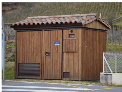
Exemple de local pour transformateur électrique
