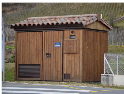
Exemple de local pour transformateur électrique
