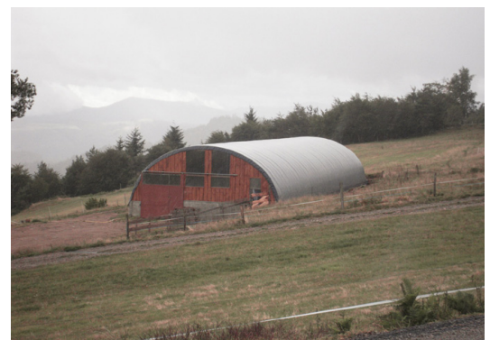
Exemple de tunnel agricole de teinte grise
