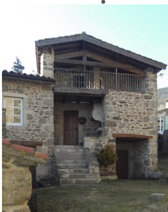
Exemple de débord de toiture
