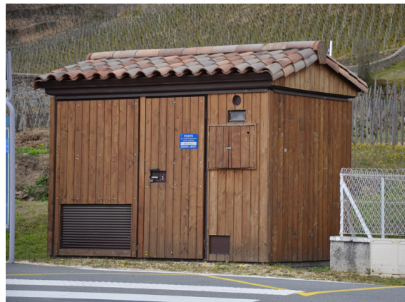
Exemple de local pour transformateur électrique
