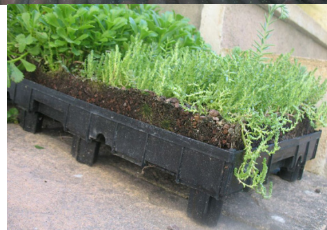
Exemple de toiture-terrasse végétalisée et bacs pré-cultivés
