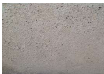
Enduit à la chaux brossé.
