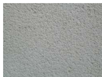
Enduit à la chaux gratté fin.
