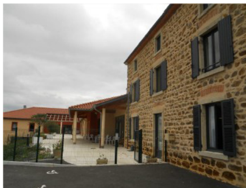
Vue sur la Maison d'Accueil pour Personnes Agées depuis la rue des Lumières : façade en pierres de pays, rangée de briques au-dessus des linteaux, bordures de fenêtres en briques,...
