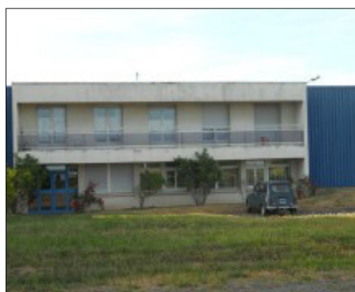
Vue sur les logements collectifs construits en continuité du bâtiment Linder
