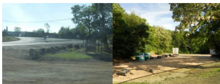
L'aire de pique-nique aménagée sur la RD1082, une voie de passage importante : un point d'étape qui constitue un point d'appel vers le centre-bourg. Un espace à préserver et valoriser dans le cadre du développement touristique de Saint Marcel de Félines.
