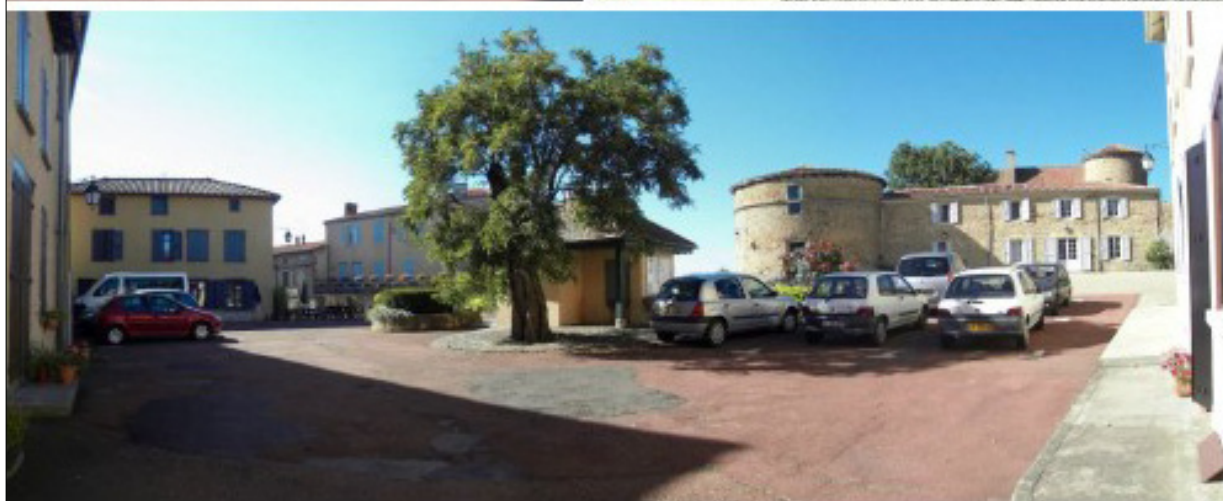
Château, église, mairie, foyer La Roche, commerces, stationnement... la place centrale du bourg est un véritable lieu de vie, pourtant scindé en deux par la RD n°5
