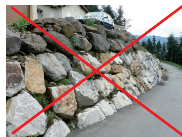
Exemple d'enrochements de type cyclopéen
