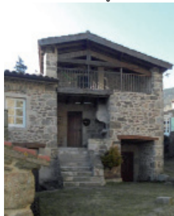
Exemple de débord de toiture
