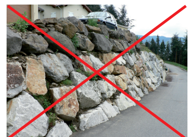
Exemple d'enrochements de type cyclopéen
