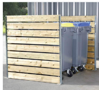
Exemple de traitement d'un espace pour poubelles
