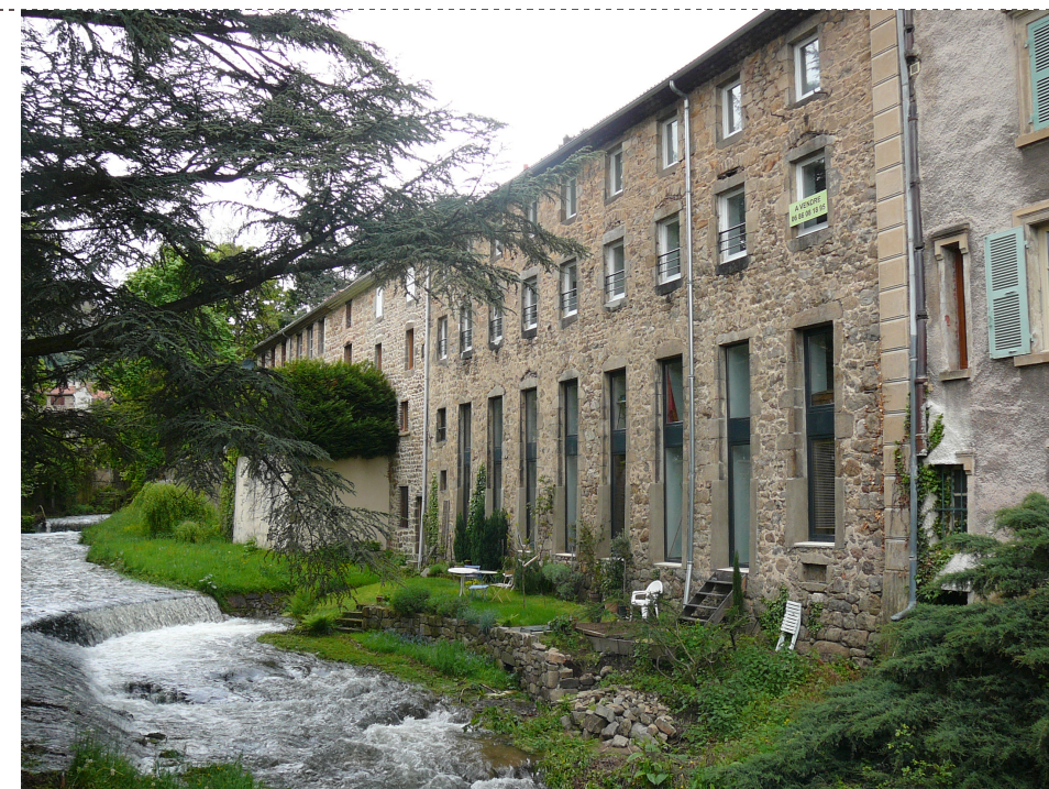
Anciennes usines réhabilitées et berges du Ternay
