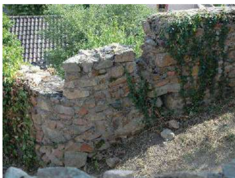
Meurtrières obstruées par des remblais qui pourraient dissimuler des salles.
