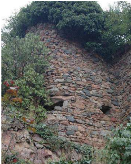
Tour au sud de l'enceinte ouest
