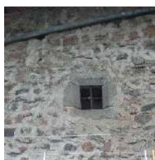
Ouverture dans le mur nord
