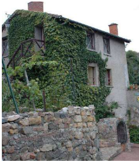
Bâti du XVII e siècle : Maison (Parcelle 1963, ruelle de la Mure)
