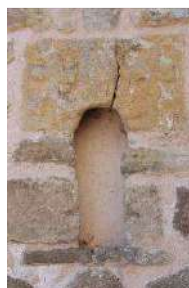
Baie murée du chevet, à linteau gravé de croix de Malte
