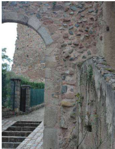
Arrachements de mur pouvant appartenir à la deuxième enceinte
