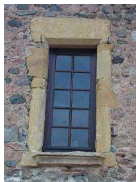
Facade sur rue: fenêtre du XV e siècle
