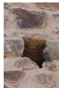
Trou de boulin surmonté d'une dalle avec des traces de taille en chevron.
