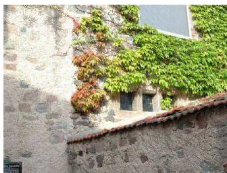
Fenêtre à meneau de la façade sur cour
