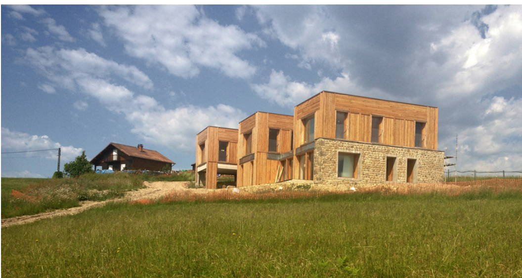
Logements individuels groupés, Bertignat (63)
