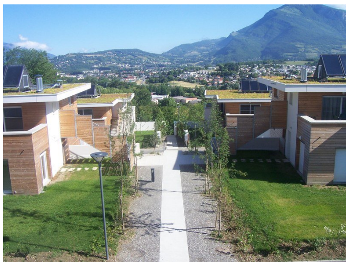
Logements intermédiaires ; La Ravoire
