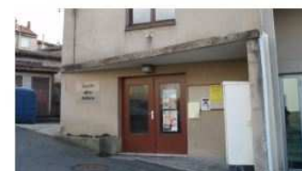
Vue de l'entrée de la salle Bouthieu
