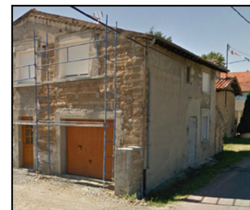
Recours au pisé
