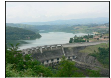
Le barrage de Villerest et sa retenue
