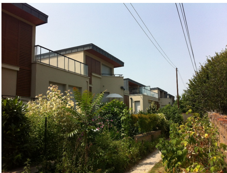
Logements intermédiaires – Croix Rousse, Lyon
