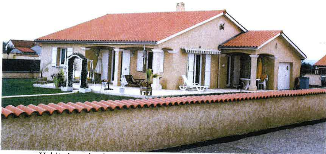
Habitation très récente du Bourg avec respect de certaines formes architecturales et couleurs de l'habitat traditionnel (couleur de crépit claire, toit à 2 pans, muret avec chapeau en tuiles canal)
