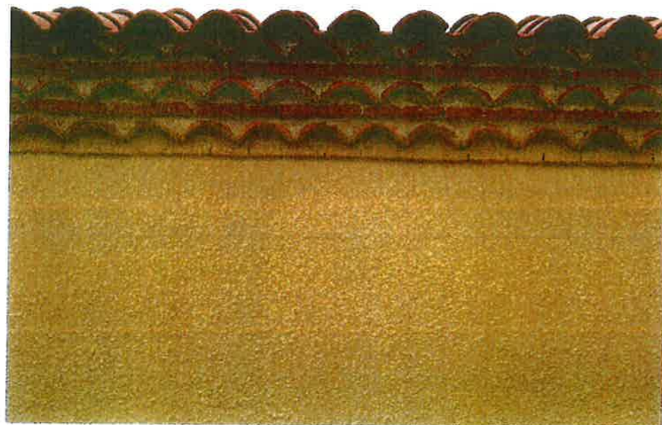
Détail d'une généoise à 3 rangs au faitage des murs gouttereaux
