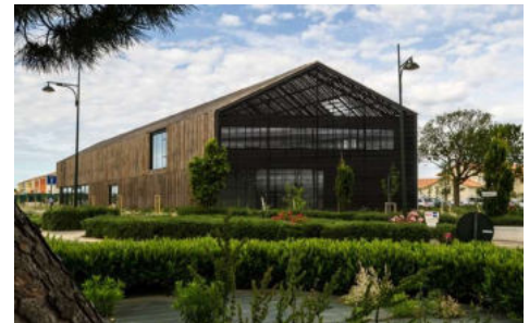
Salorge, siège de la Communauté de Commune de Pornic (44) par Atelier ARCAU // © LE RESTE Hervé
