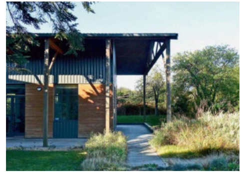
Entreprise de menuiserie à Saint-Vincent-des-Landes (44) par Philippe Misériaux, architecte
