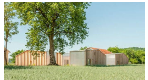
Transformation d'une gare en gîtes et salles d'exposition à Leuglay (44) par Adelfo Scaranello
