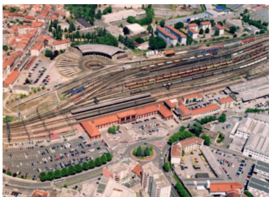
Gare et faisceau ferré
