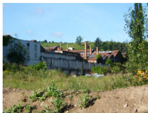
Ancienne usine de ressorts
