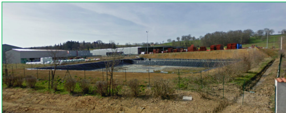
Zone d'activités intercommunale de Saint-Denis-de-Cabanne
