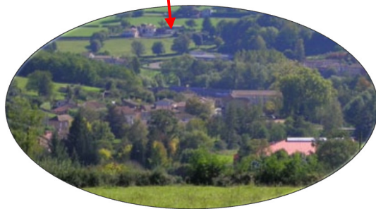
Les Carrières, quartier séparé du reste du bourg par le Botoret
