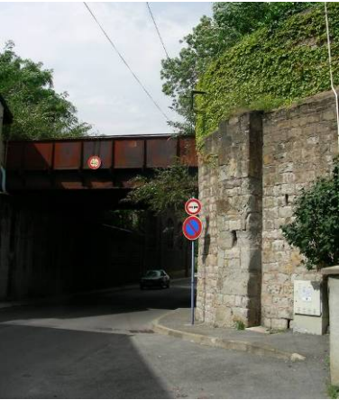
Passage inférieur de l'ancienne voie ferrée du GIAT Rue Pétin Gaudet
