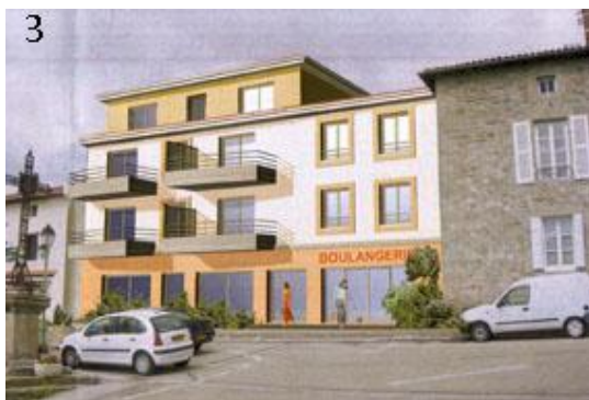
Photo 1 : la nouvelle mairie Photo 2 : l'espace sylvestre Photo 3 : réalisation de 8 logements sociaux et d'un commerce
