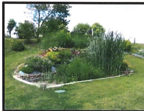
Exemple de phytoépuration
