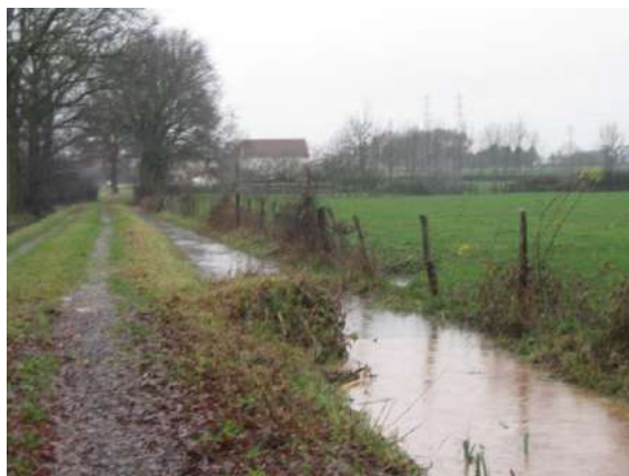
Fig. 29. Débordement de fossé – chemin de Maupassant
