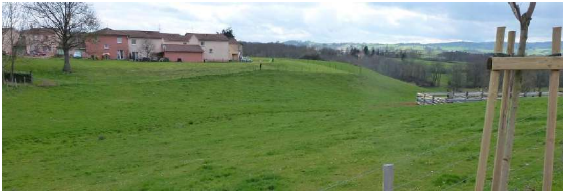
Fig. 34. Ravinement du thalweg au droit d'une parcelle agricole en aval du bourg
