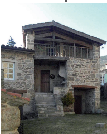
Exemple de débord de toiture
