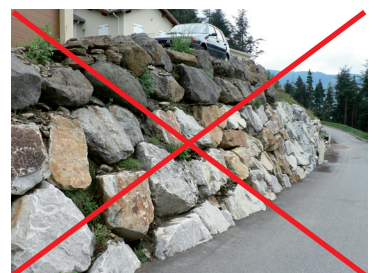
Exemple d'enrochements de type cyclopéen
