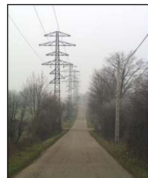
D'anciens poteaux électriques surplombant la route des crêtes sur le plateau
