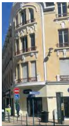
Immeuble Art Nouveau : façade enduite
