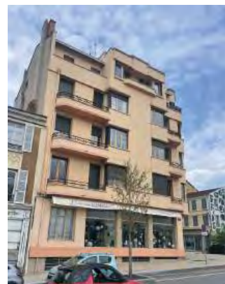
Immeubles Art Déco
