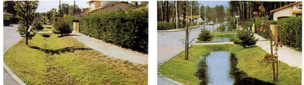
Exemples de traitement des eaux pluviales sous forme de noue ou de surfaces
