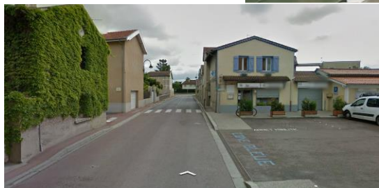
Traversée du bourg par la RD 101
