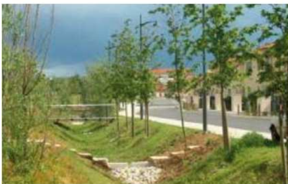
Fossé drainant paysagé pour rétention des eaux pluviales en bordure de l'espace public.
