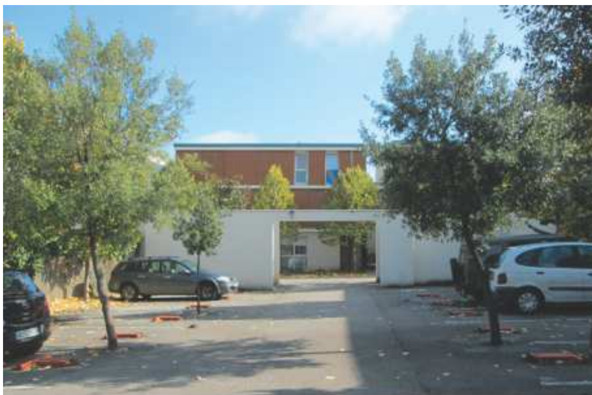
Une aire de retournement prenant la forme d'une voie bordée de stationnements paysagers.
