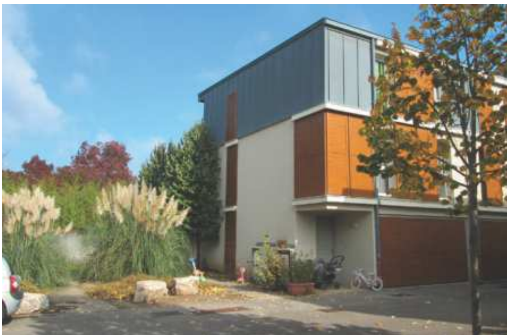
Espace de jeu à l'allure de jardin servant aussi d'espace de rétention des eaux pluviales.
