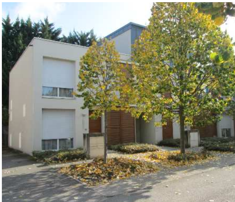
Espaces de transitions paysagers (arbres à hautes tiges / parterre plantés) entre la rue et les logements + intégration urbaine des coffrets électriques servant à délimiter les entrées dans les logements et à séparer le logement de la rue (à la place des traditionnelles clôtures).
