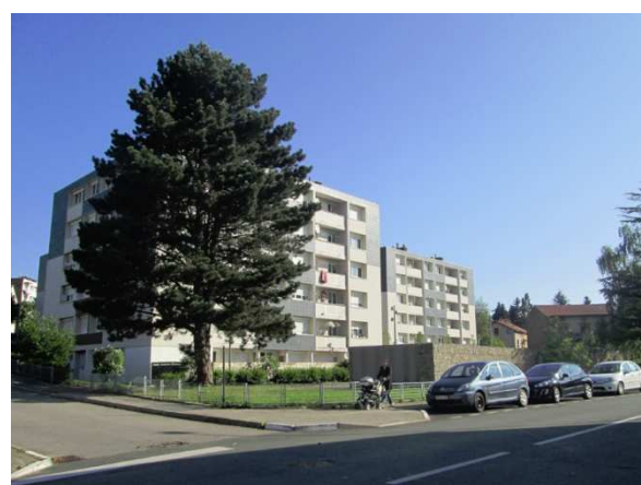
Habitat social sous la forme de collectifs récents (années 60/70), Rue M. Thorez
