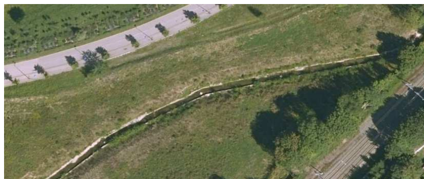
Ondaine canalisée à Montrambert
