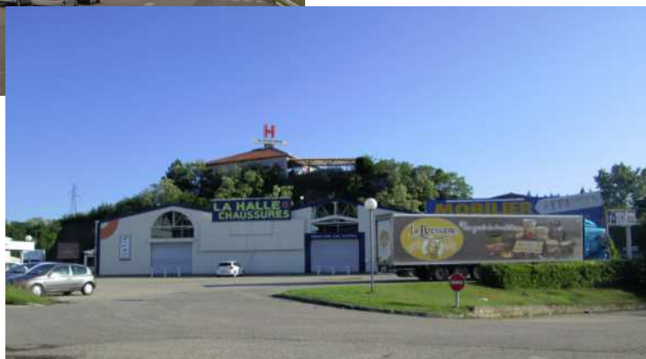
Partie nord de la zone commerciale de la Béraudière
