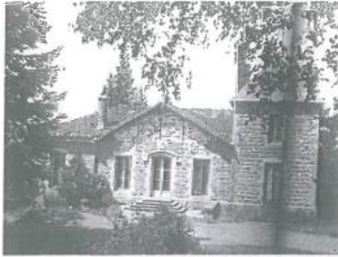
Façade sud Façade nord Vues anciennes
