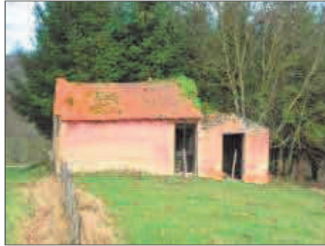
Voie communale de Verrières
