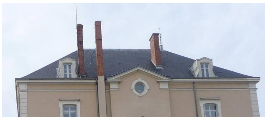
couverture en ardoise...
