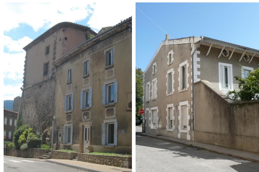
Exemples d'architectures ne pouvant supporter une ITE : isolation thermique par l'extérieur, sans subir la perte d'éléments patrimoniaux.
