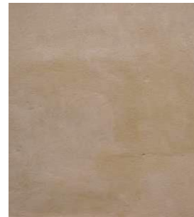
enduit lissé à la truelle
