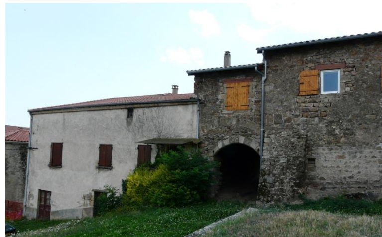
Galleries voutées (château de la Valette)
