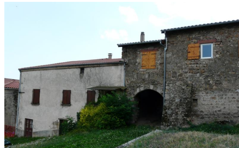
Galleries voutées (château de la Valette)
