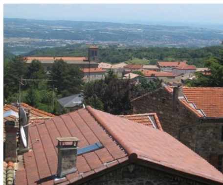
couverture en tuile mécanique
