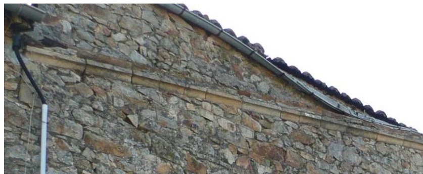
Dépassées de toitures
