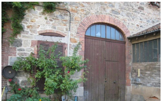
Utilisation de la terre cuite à Pélussin
