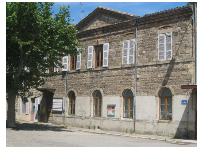
Immeuble, place des Croix
