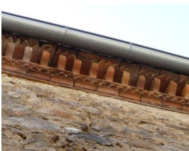
Différentes typologie de dépassées de toiture : en bois avec chevrons apparents, en pierre de taille (très rare) ou plus couramment en brique...
