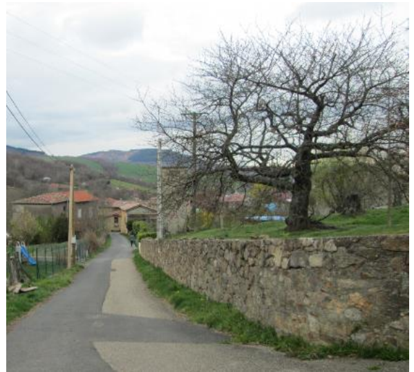
Murets en pierres sèches traditionnels, servant à la fois de soutènement et de clôtures : modèle d'intégration dans le site.
