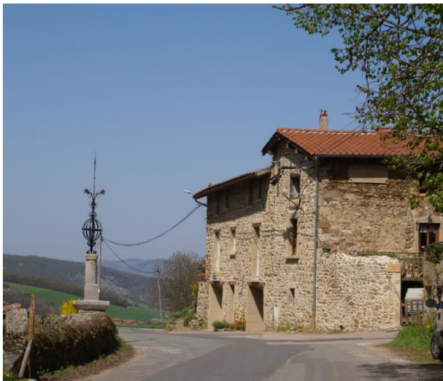
Bâtisse villageoise marquant l'entrée dans le village de Pavezin = simplicité des volumes, qualité de construction (maçonnerie, toitures).
