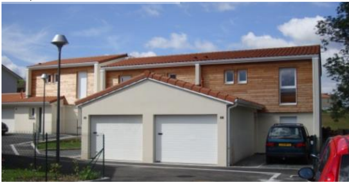
Exemple de maisons accolées par le garage, d'aspect de bâtisses villageoises - (Saint-paul-en-Jarez).
