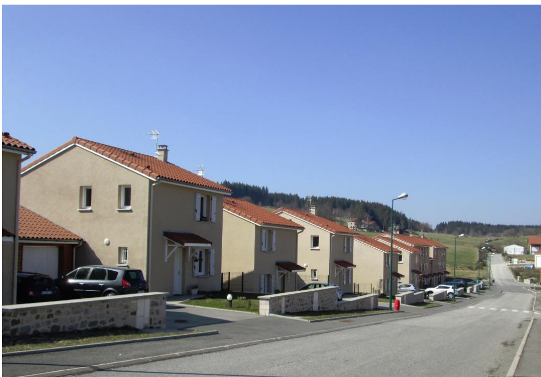
Exemple d'opération contemporaine adaptée à un contexte rural : maisons de volumes simples, réutilisation du principe de «murets» pour traiter la limite entre la rue et les logements. Il est à noter l'intégration des coffrets à la clôture pour une plus grande qualité urbaine - (Opération les Sources - Saint-Genest-Malifaux).
