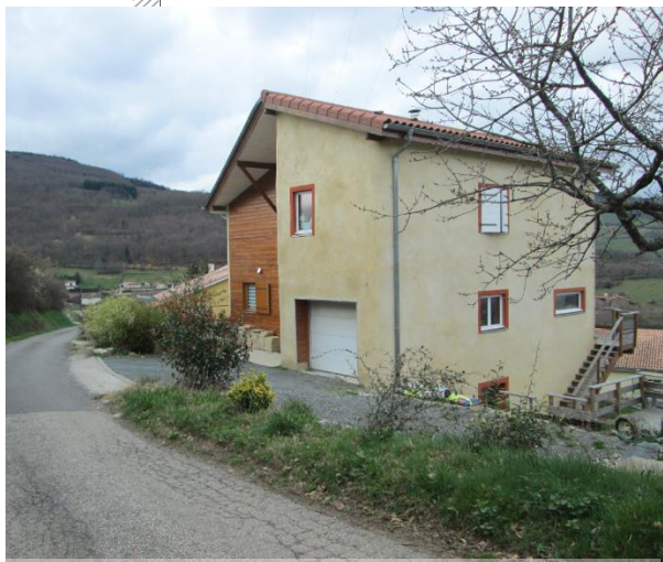
Exemple de maison individuelle récente avec qualité d'intégration dans le site - (Commune de Pavezin).
