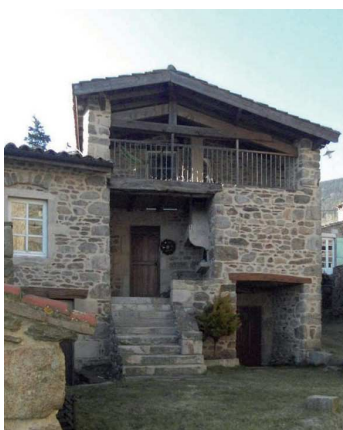
Exemple de débord de toiture
