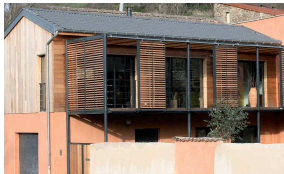
Exemple de loggia
