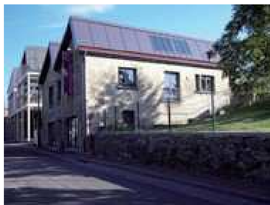
Exemple de toiture en shed
