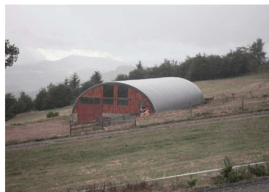
Exemple de tunnel agricole de teinte grise
