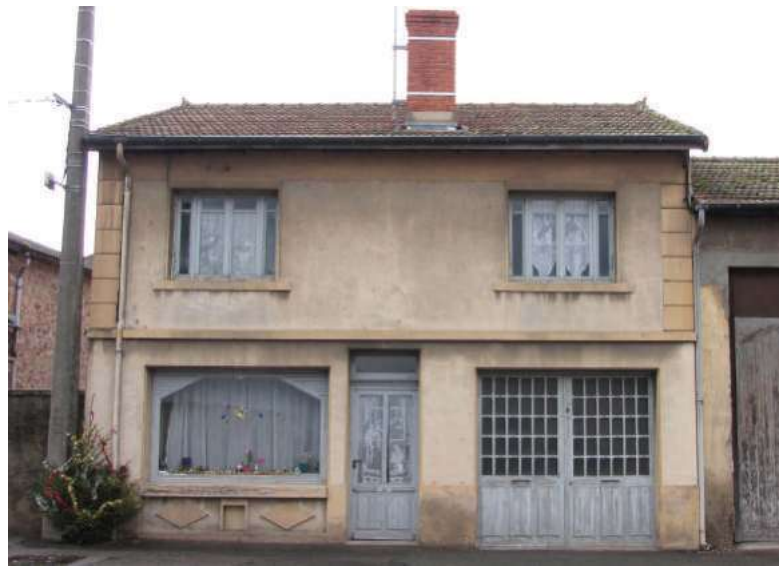
2- Menuiseries détails remarquables parcelle 413
