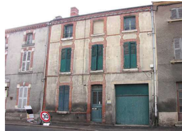
6- Ensemble des bâtiments marquant l'entrée du centre bourg, bâtiment caractéristique parcelles 46, 47, 50 51, 53 et 54.
