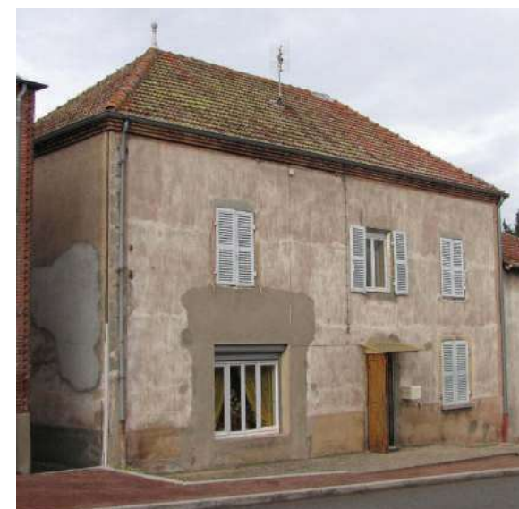
9- La Gare, bâtiment caractéristique parcelle 45
