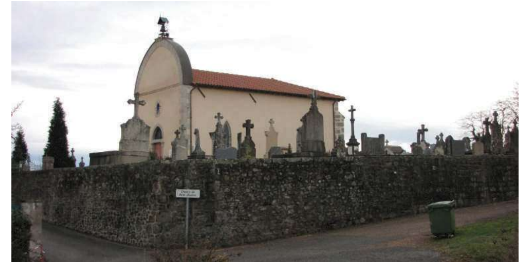
3- Tourzy, chapelle bâtiment remarquable parcelle 201 et murs de clôture parcelle 202
