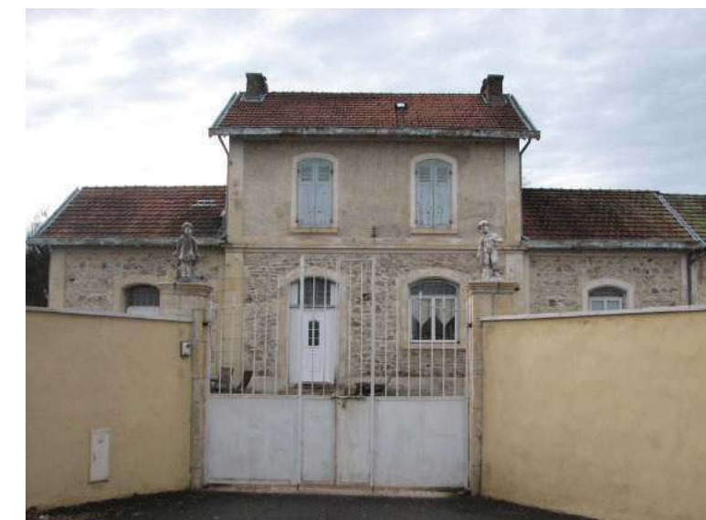
11- La Gare, bâtiment caractéristique parcelle 564
