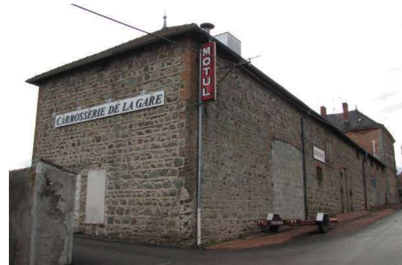
3- La Gare, bâtiment caractéristique parcelle 437
