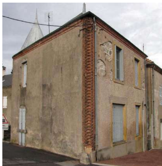
8- La Gare, bâtiment caractéristique parcelle 44 + détail remarquable tourelle
