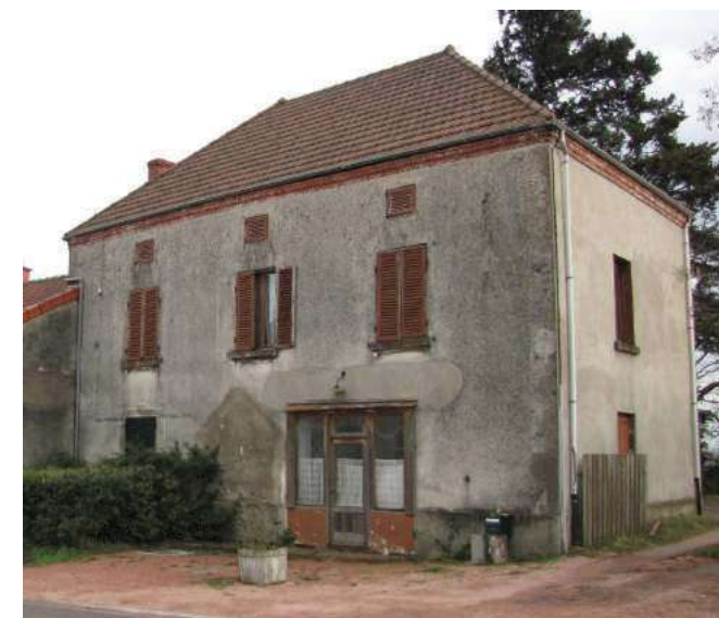
10- La Gare, bâtiment caractéristique parcelle 405
