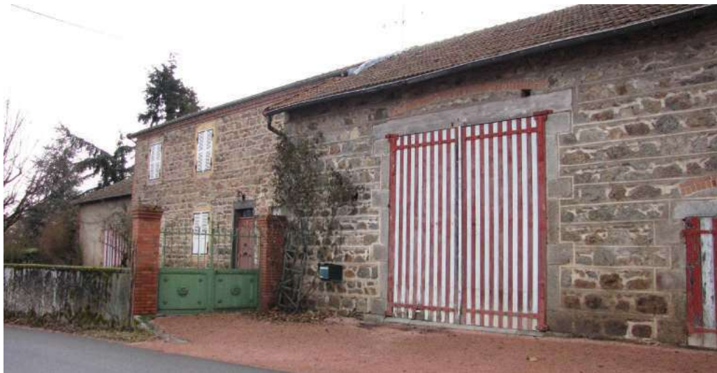
12- La Gare, bâtiment caractéristique parcelle 37
