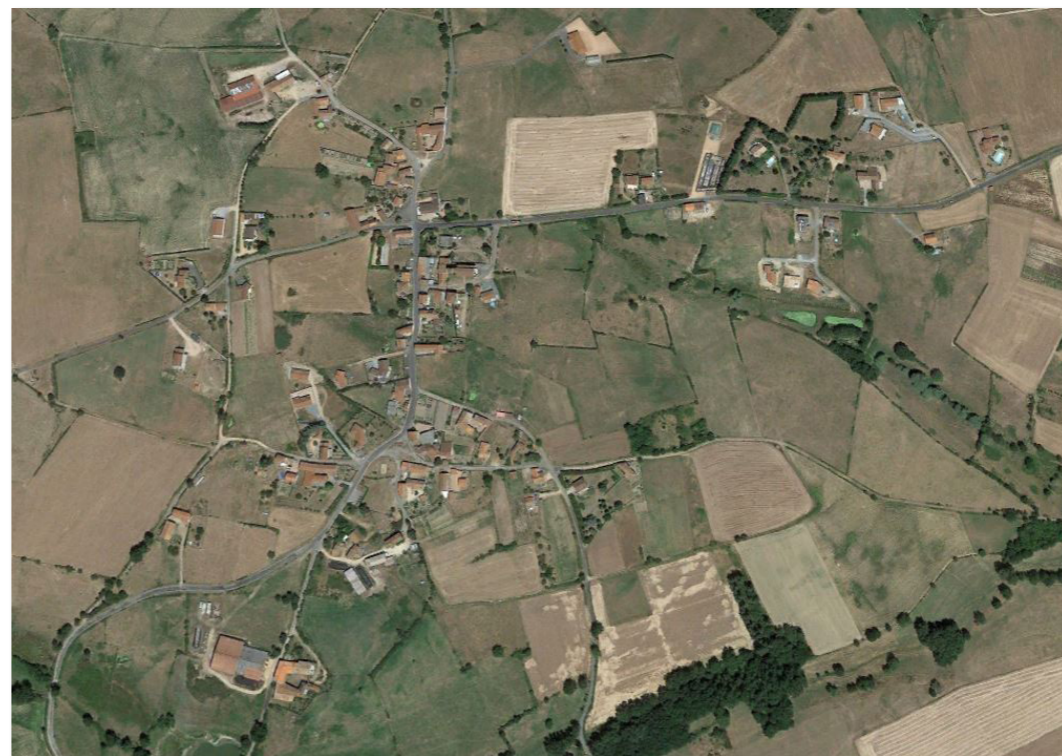
Vue aérienne centre-bourg de Nollieux en 2015
